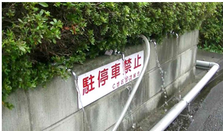
写真6：臨時給水栓 (右側=管理事務所側)
