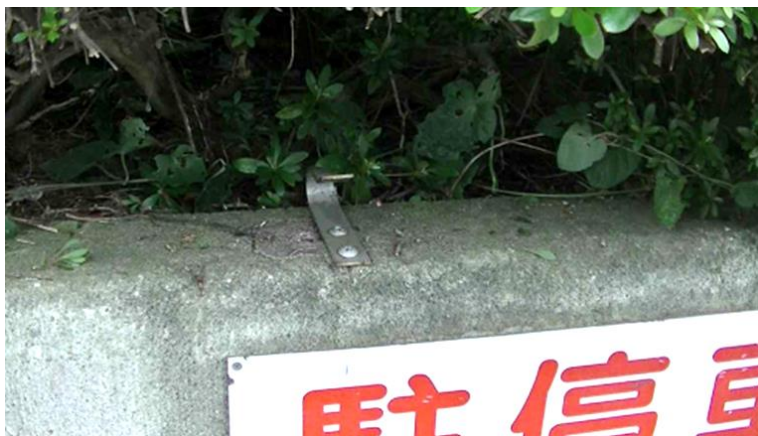
写真2：臨時給水栓の取付金具
